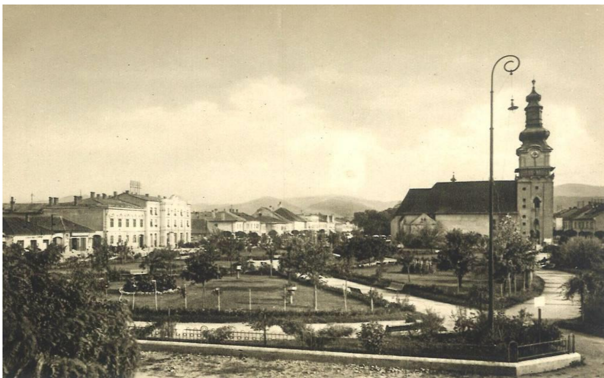
Obr.č.29 – Záber na časť ozdobného zábradlia na námestí vo Zvolene, ktoré realizovala firma Aladár Šteflík –Továrň na železné konštrukcie a inštalačné podniky, pohľadnica cca rok 190. / vydavateľ Knihkupectvo Haas, Zvolen /
