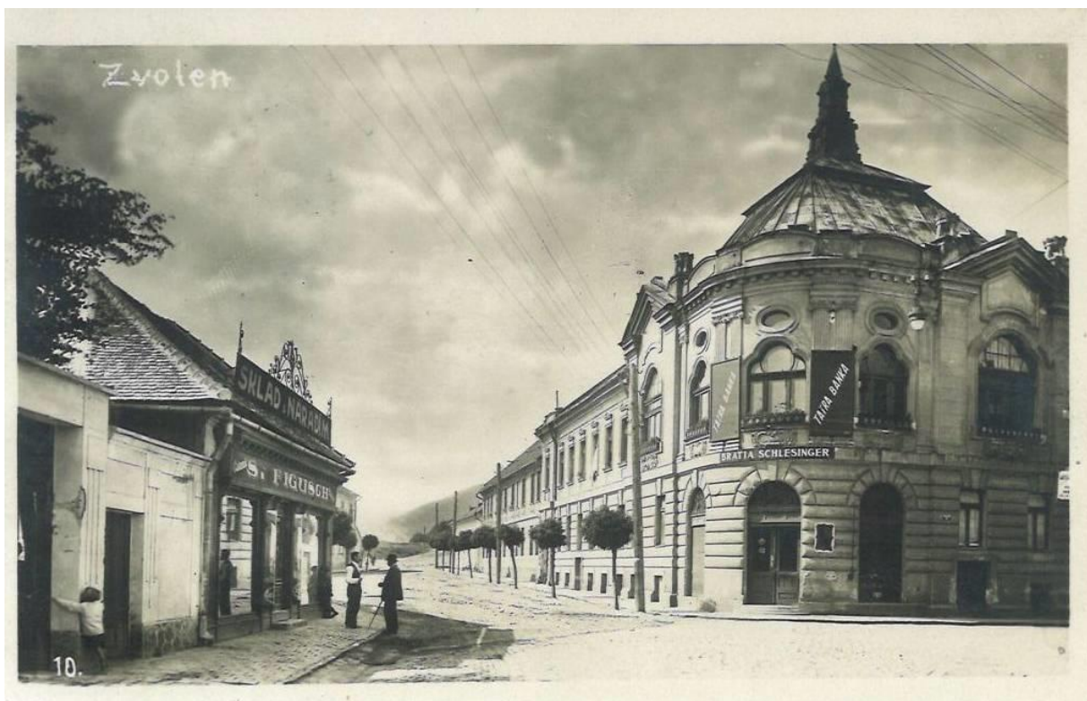
Obr.č.22 - Budova firmy Figush & syn, v ktorej sídlil obchod a výrobné dielne / pohľadnica cca rok 1935 /
