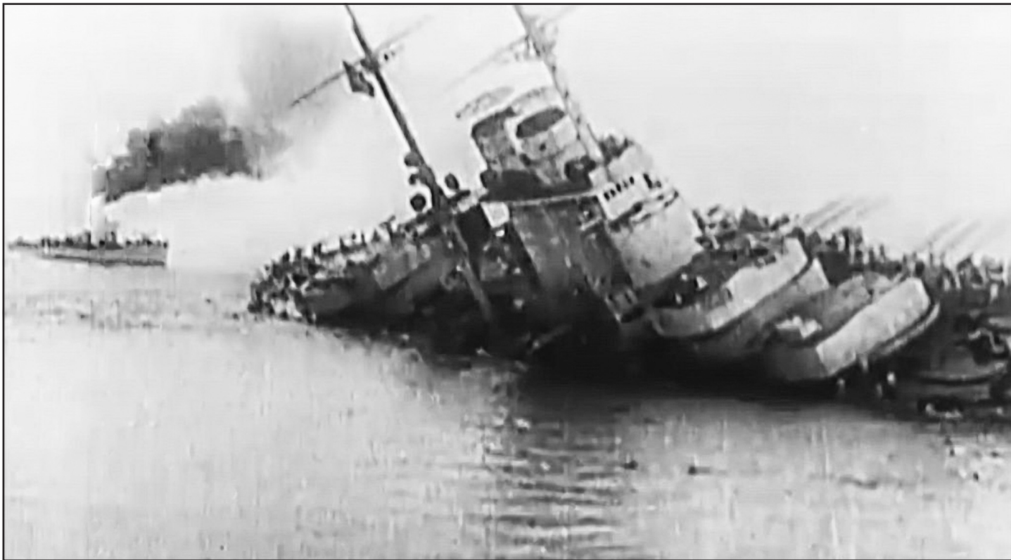
Veľké delové veže ručne otočili dol'ava, aby sa zvýšila stabilita lode s použitím ťažkých hlavní ako protizávažia.
